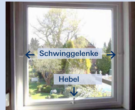
Bild 4: Schwingfenster ohne Dichtung
