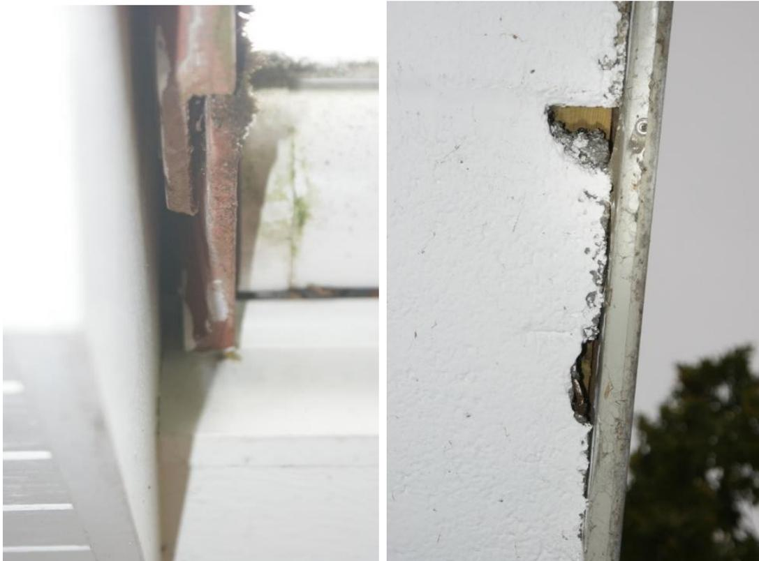
Abbildung 5: Dachüberstand/Giebel der Südseite des Einfamilienhauses (links) und potenzielle Einflüöffnungen (bis 3 x 5 cm) am Dachüberstand des Schlosserei-Gebäudes (rechts), Fotos: S. Haberstroh (14.10.2016)
